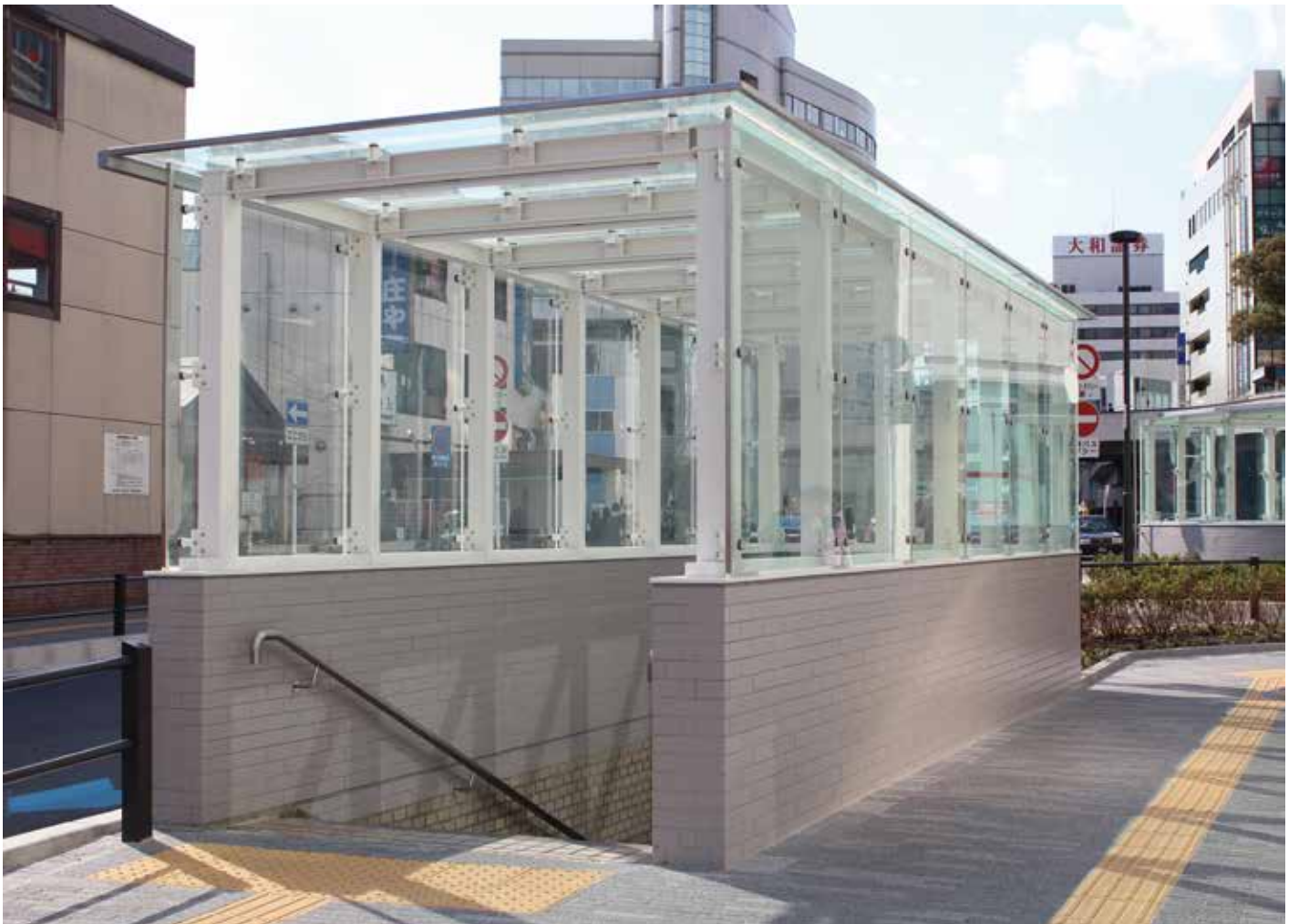
▲ 藤沢駅前地下道シェルター
